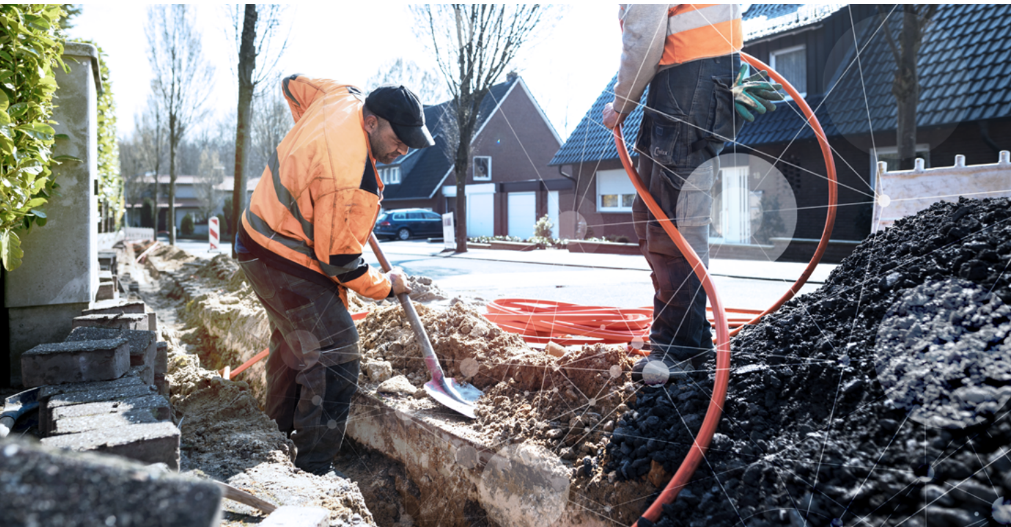
Eine Glasfaserbaustelle im Münsterland; Der Ausbau leistungsfähiger Gigabitnetze mit schnellen Datenverbindungen soll zügig vorangehen.
