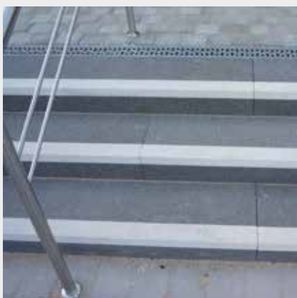
Die Stufenvorderkanten der Betonblockstufen im Außenbereich sind kontrastreich markiert
