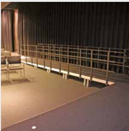
Der Bühnenzugang ist mit Hilfe einer Rampe und beidseitigen Handläufen schwellenfrei möglich
