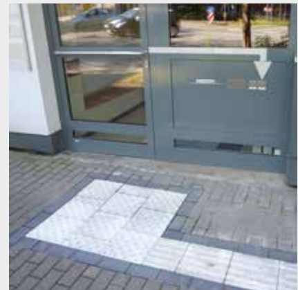
Ein Noppenfeld weist auf die Eingangstür und die rechts angeordnete Klingel hin
