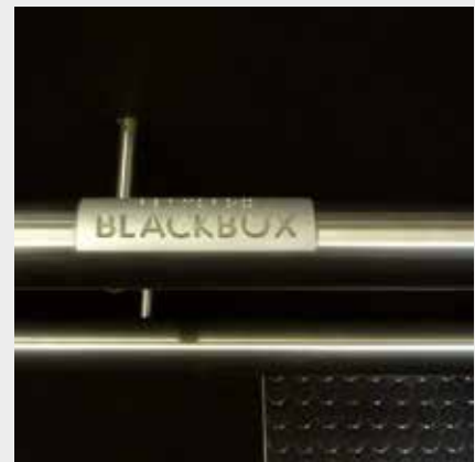
Am Beginn und Ende einer Rampe sind tastbare Hinweise zur Orientierung hilfreich
