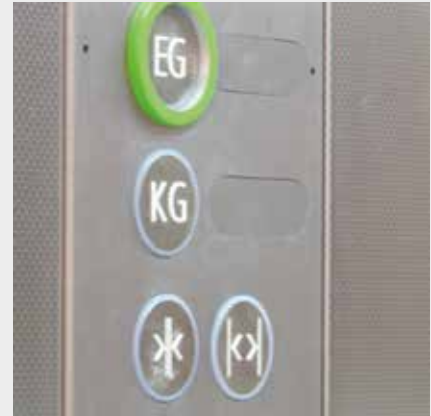
Diese Tasten, darunter die Erdgeschoss-taste (Gebäudeausgang), sind für blinde Menschen gut tastbar
