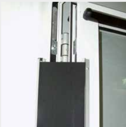
Die Schutzvorrichtung im Scharnierbereich einer Automattür verhindert Verletzungen durch Quetschungen
