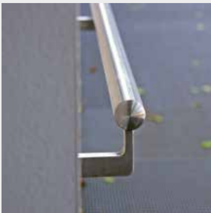
Als gut greifbarer Handlauf hat sich ein Rundrohr mit einem Durchmesser von 3,0 cm bis 4,5 cm bewährt
