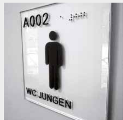
Das tastbare WC-Schild sollte neben der Tür auf der Seite des Türdrückers in 130 cm bis 160 cm Höhe angeordnet werden
