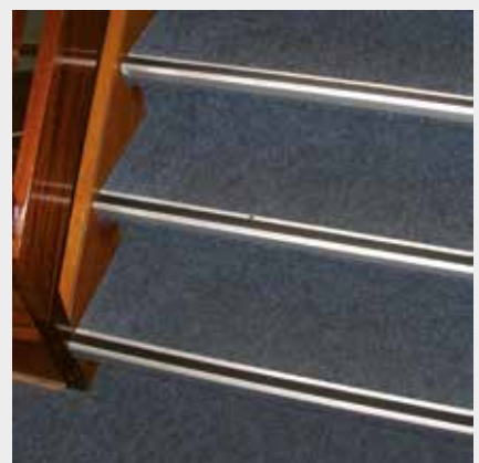
Das Winkelprofil aus Aluminium dient als kontrastreiche Stufenvorderkante auf einer Treppe mit Nadelfilzbelag
