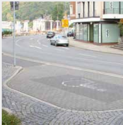
Der Stellplatz ist schwellenfrei an den Bürgersteig angebunden, doch das Kleinpflaster ist nicht erschütterungsarm befahrbar
