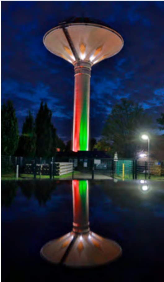
Der Wasserturm Leverkusen ...
